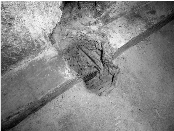
Photo 2.3. Exemple de sondage destructif
